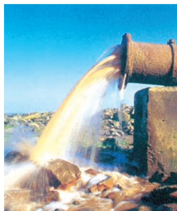
■ Fig. 4 – Deversarea apelor reziduale — sursă importantă de poluare
