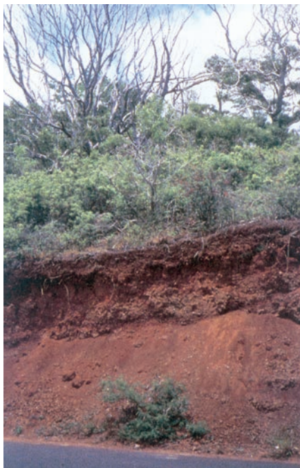
■ Fig. 3 – Eroziunea laterală a unui versant
