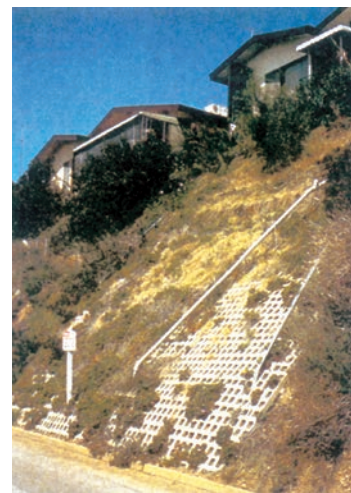
■ Fig. 1 – Lucrare ameliorativă de protecție a unui versant
